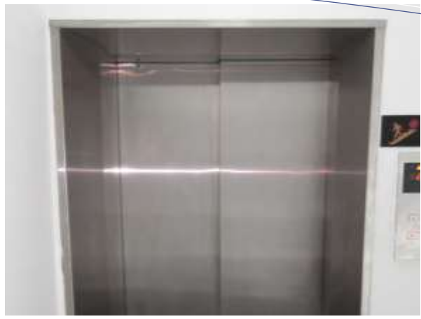
Architrave door cladding
